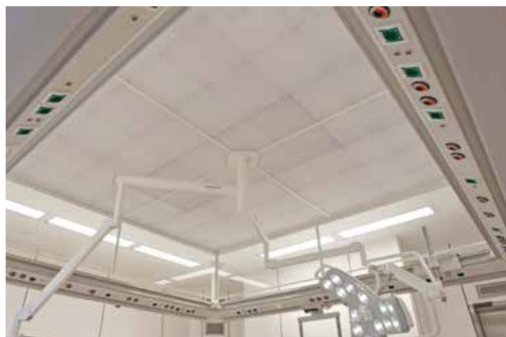
TAV-Decke mit umlaufender Medienbrücke/ Laminar air flow ceiling with circumferential media bridge
